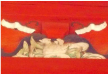
勝福寺本堂の装飾の塗装(施工前)
