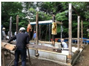
移築復元工事
